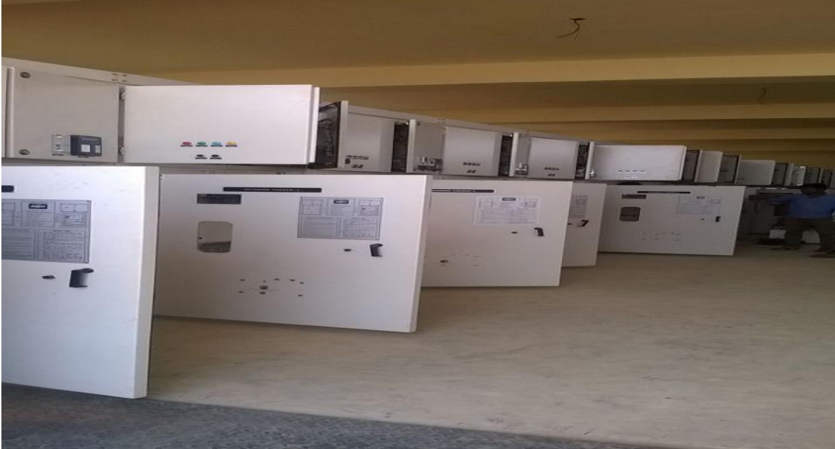
33 kV Switchgear
